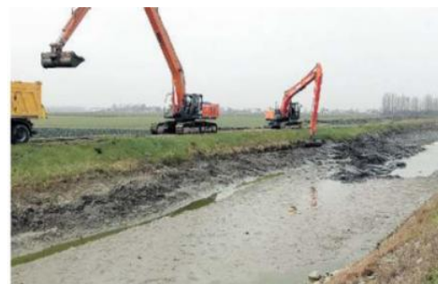
SIQUEZZA IDRAULICA per il territorio della Saccisica: le ruspe al lavoro lungo il canale Altipiano
