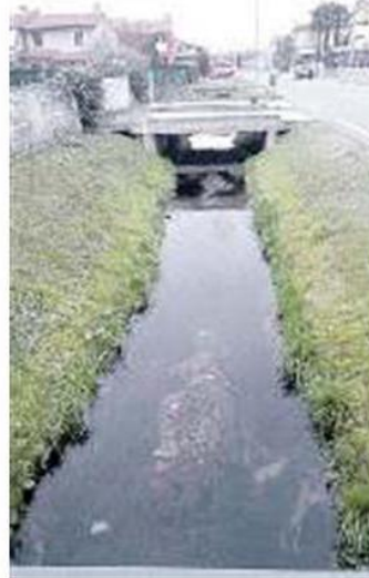
IL SITO Lavori sul rio Chioro
