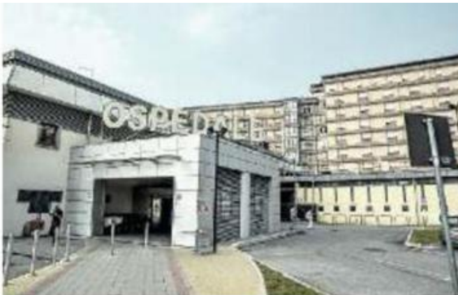
I CANTIERI La Provincia realizzerà la passerella ciclopedonale
