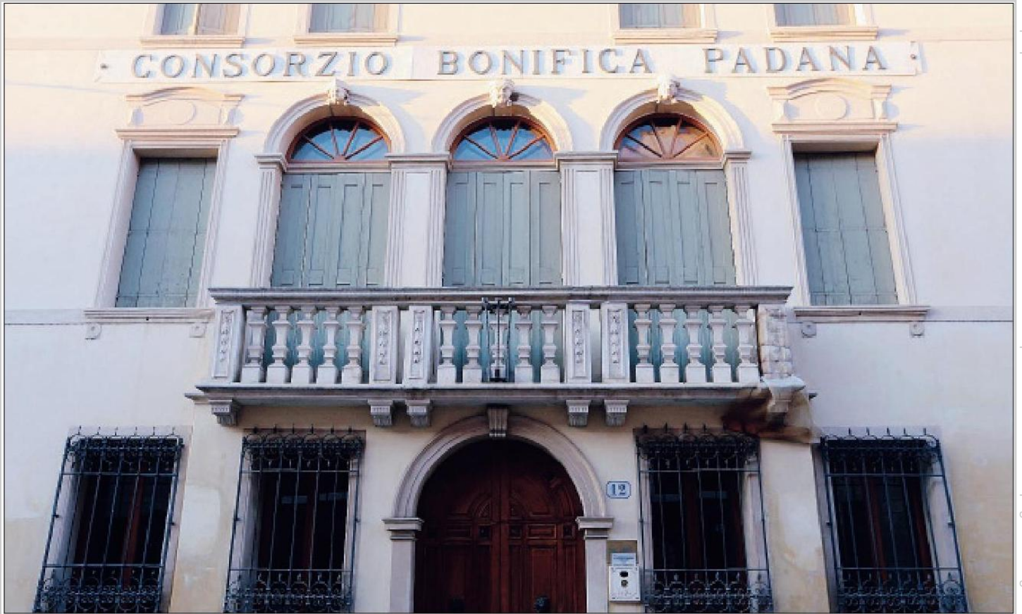
L'ex sede del Consorzio di Bonifica Padana sarà assegnato agli uffici della Procura e della polizia giudiziaria di Rovigo
