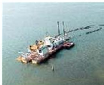
PILA Escavi attesi
