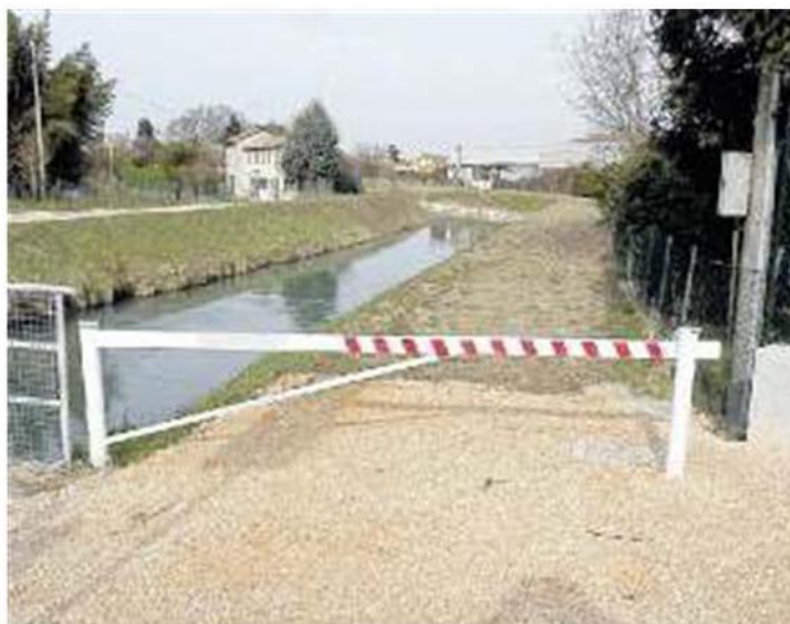
PROBLEMA ANNOSO Uno degli sbarramenti posti lungo gli argini
