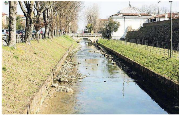
La fossa esterna alle mura nella zona di porta San Tomaso durante la chiusura dei canali irrigui collegati al Piave. In queste ore il livello dell'acqua dovrebbe ritornare alla normalità
