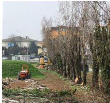
Un momento dell'intervento di potatura dei pioppi
