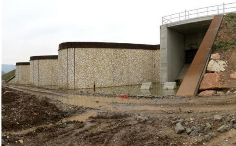
Le paratie del bacino di laminazione di Colombaretta. FOTOGRAFIA DI VINCENTO ZAMMATO
