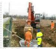
Uno degli interventi in corso
