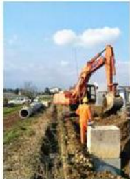
La posa di alcune tubature
