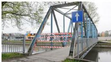
La passerella sul canale Bussé chiusa al transito di auto, bici e pedoni
