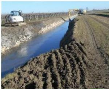
L'intervento lungo lo scolo Fossa Lunga del Consorzio di bonifica
