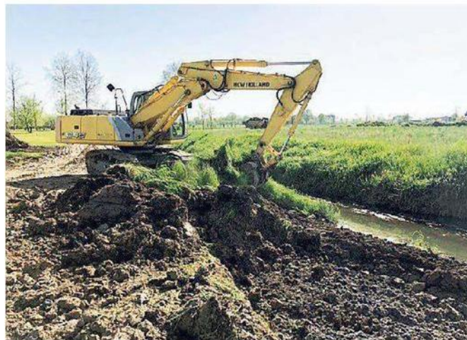
Le ruspe del Consorzio Acque Risorgive all'opera nella Fossa dei Marai
