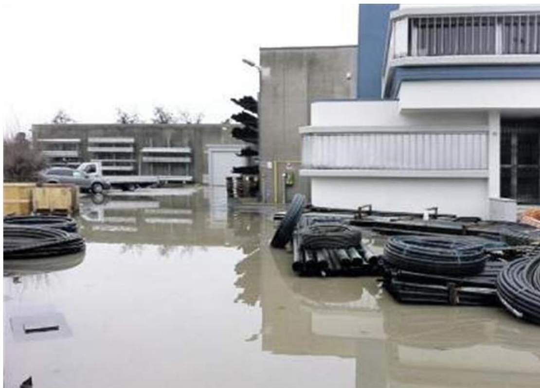
SICUREZZA IDRAULICA In Via Sant'Antonio nel 2014 abitazioni e aziende furono invase dalle acque
