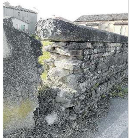
PONTE STORICO La portata è stata ridotta da 4 a 2 tonnellate per i mezzi in transito in ragione dei problemi di staticità del manufatto
