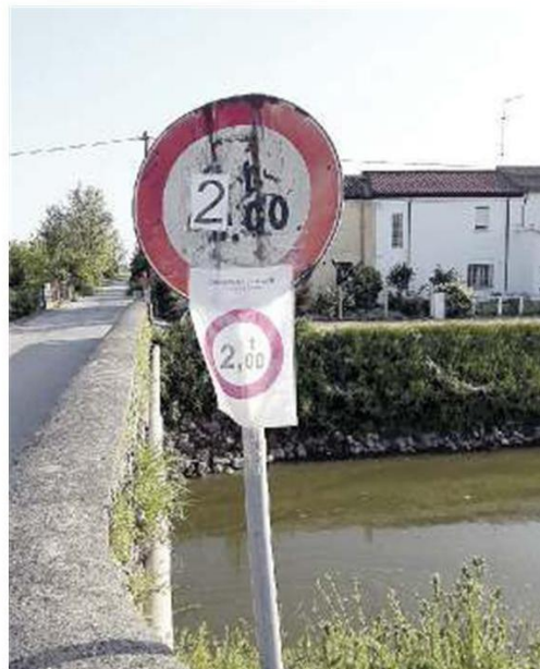
PONTE STORICO La portata è stata ridotta da 4 a 2 tonnellate per i mezzi in transito in ragione dei problemi di staticità del manufatto
