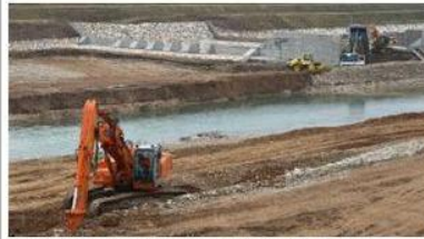
I lavori di costruzione del bacino di laminazione di Trissino
