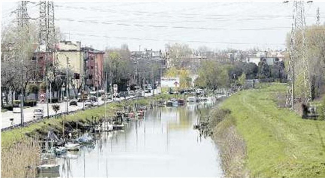
L'OSSELLINO Il corso del fiume lungo via Vespucci, le rive stanno crollando e i fondali sono inquinat
