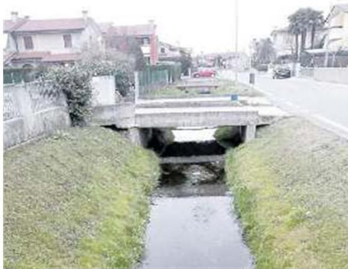
L'INTERVENTO I tecnici del consorzio sono al lavoro sul rio Chioro
