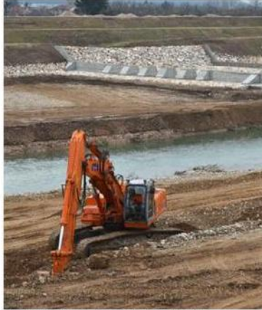
Il cantiere per la costruzione del bacino di Trissino
