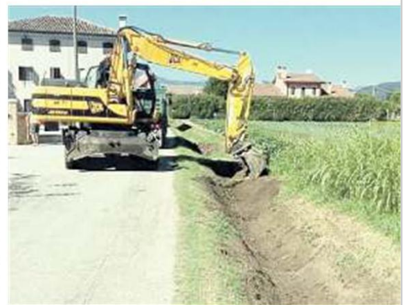
ESCAVATORI IN AZIONE Il personale del Consorzio Piave e del Genio mentre effettua la pulizia del Muson e del canale Loreggiola
