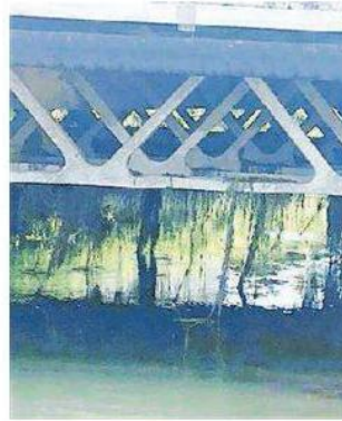
Il ponte sul Vandura a Fratte
