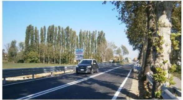
Riaperto il ponte sul Tione a Bonferraro, lungo la regionale 10 Padana inferiore
