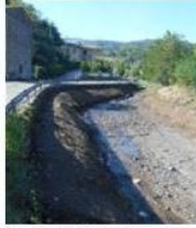
Lavori al rio Gambellara. M.G.
