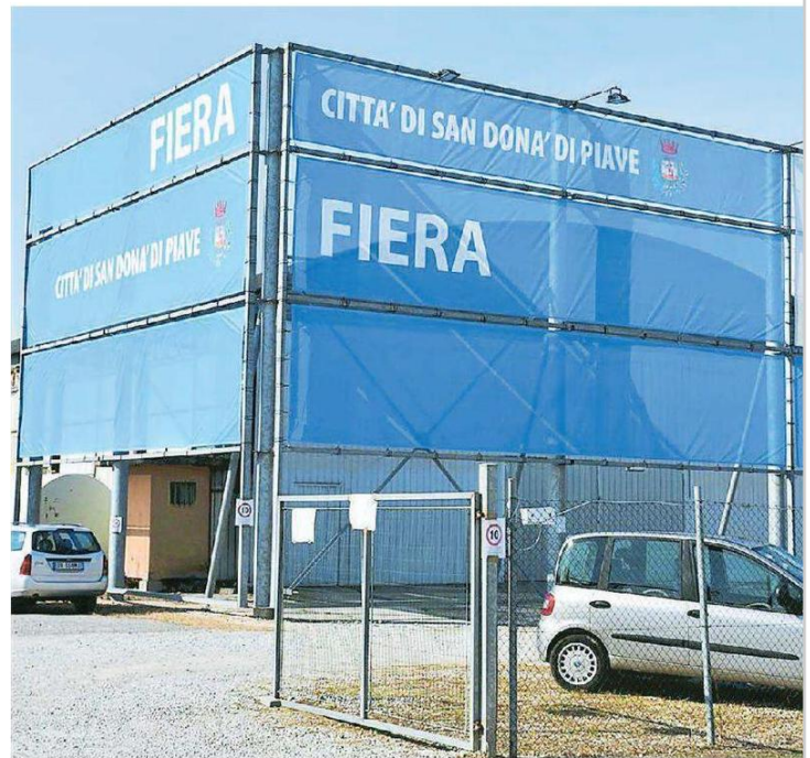
Lavori di allestimento per la fiera campionaria in via Pralungo
