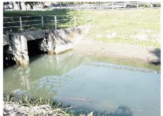
LA RETE DEI CANALI L'Adiget sta vedendo già calare il livello per il minor apporto di acqua a causa dei lavori
