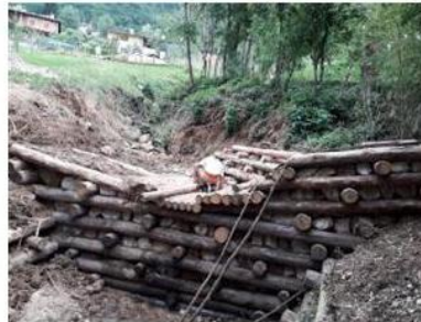
Lavori di sistemazione della roggia Marcoalda
