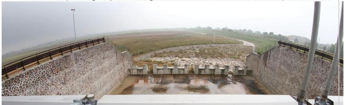
La porta d'ingresso del bacino di Caldogno in grado di invasare 3,8 milioni di metri cubi di acqua: finora non è mai stata utilizzata ma tra oggi e domani potrebbe entrare in funzione. FOTOSERVIZIO DOVIAN OSCATO
