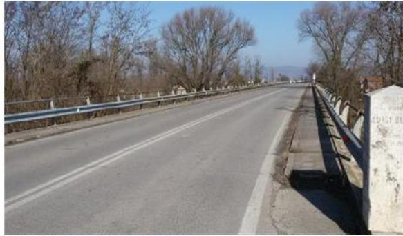
Ponte Luigi Delaini sopra l'Adige tra Belfiore e Ronco
