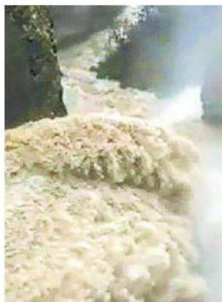
Lo sfioro della diga in Cadore
