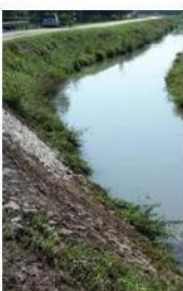
Ora i lavori sono stati ultimati
