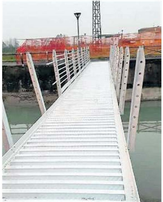
FRAZIONI La ciclopedonale tra le due frazioni è quasi completata
