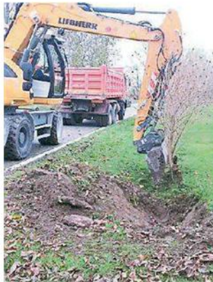
Lavori di scavo a Chiarano
