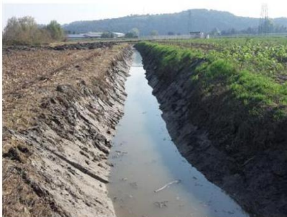
Lo scolo Mantovana tra Sossano, Villaga, Barbarano Mossano, oggetto di interventi di ripristino
