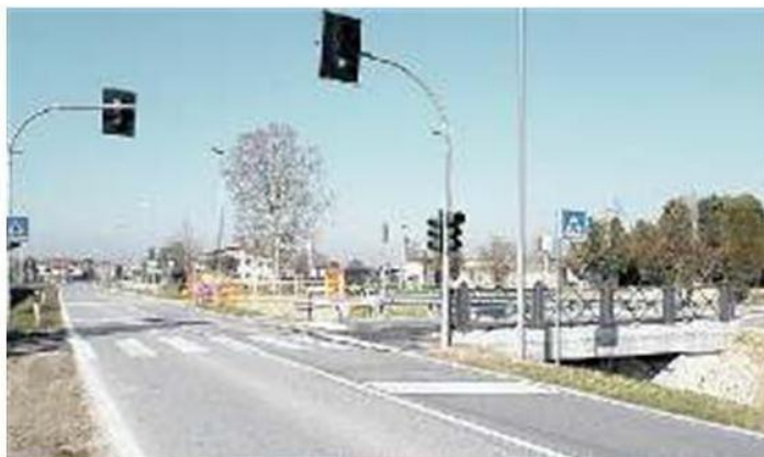
SCOLO MEDIANO Il ponticello è stato ricostruito in tempi rapidi
