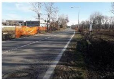
La zona interessata dai lavori
