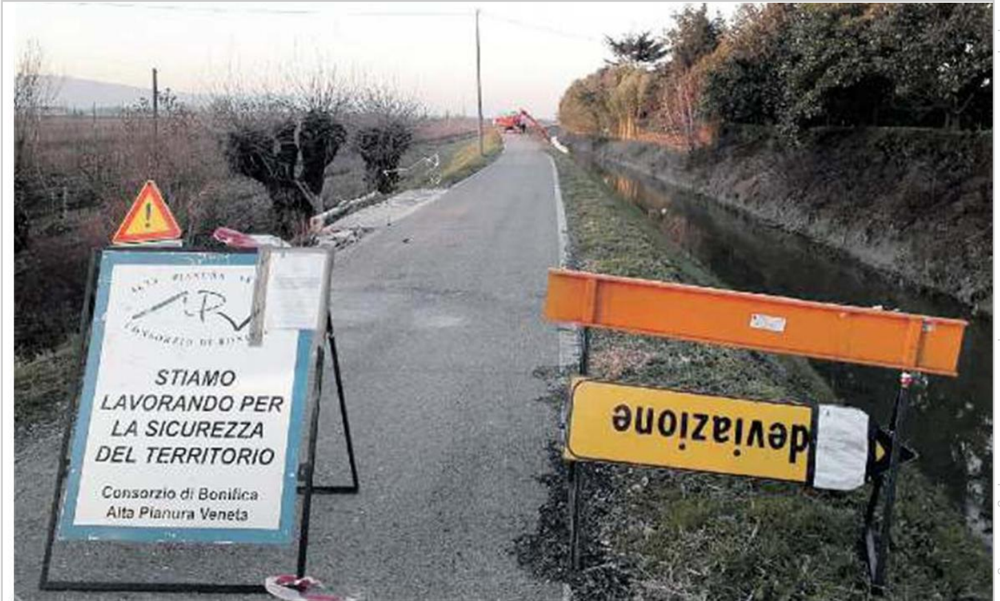
TRANSITO VIETATO Il consorzio di bonifica Alta Pianura Veneta sta lavorando lungo le sponde dello scolo Nina dove passa la pista ciclabile
