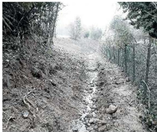
MESSA IN SICUREZZA Sul corso d'acqua che passa tra le vie Spinazzola e Torre è stato eseguito un grande lavoro di pulizia del sottofondo
