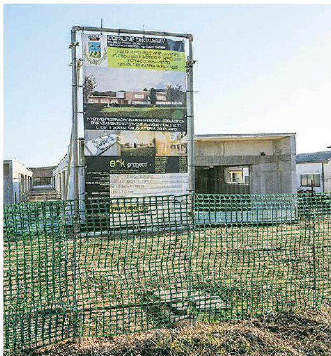
Il cantiere fermo per la nuova sede scolastica di Maser
