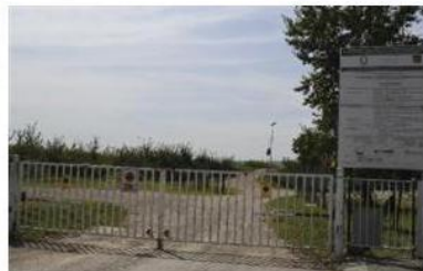
L'accesso all'area di cantiere destinata al bacino di Tezze. ARCHIVIO
