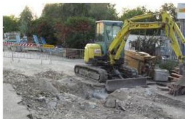
A Perarolo previsti interventi sulla rete fognaria. ARCHIVIO
