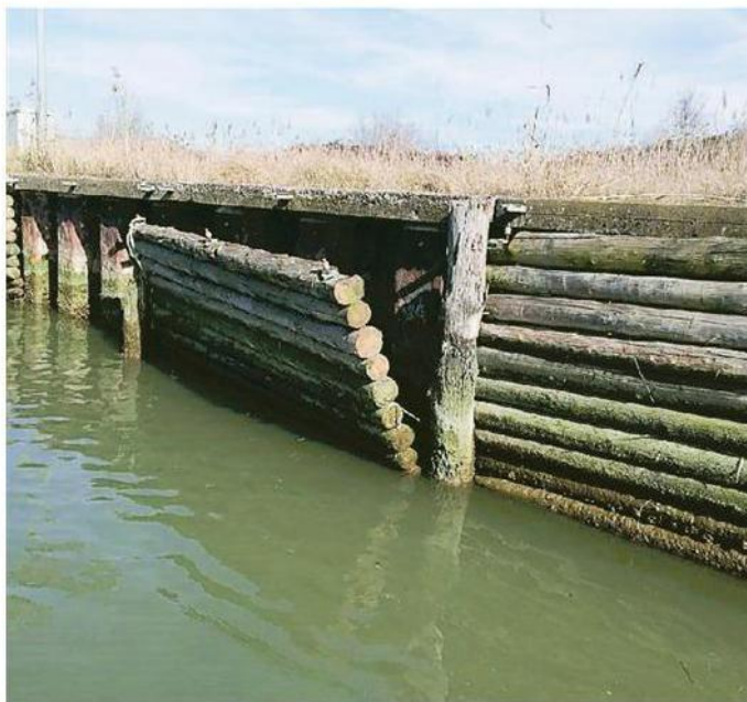
Un'intera palizzata che si sta staccando dalla riva
