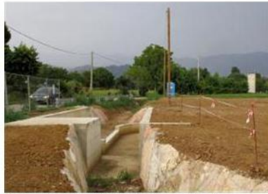
Il punto di ripartizione delle acque realizzato sul Torresino
