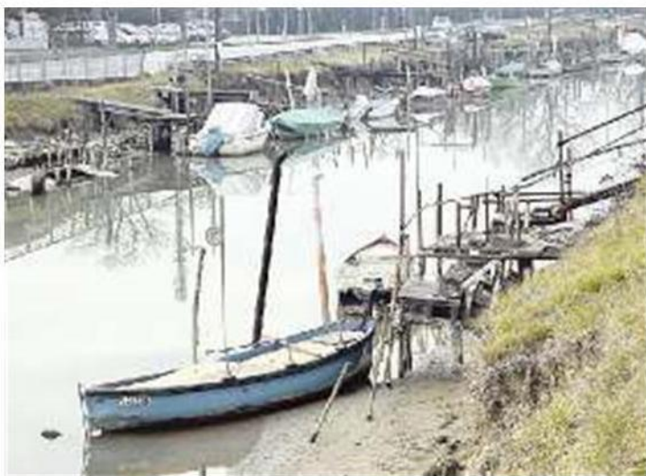
IN SECCA Sono imminenti i lavori di scavo del fondale dell'Osellino, che in questo periodo si presenta in secca
