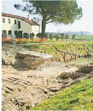
Il cantiere sullo Schilla
