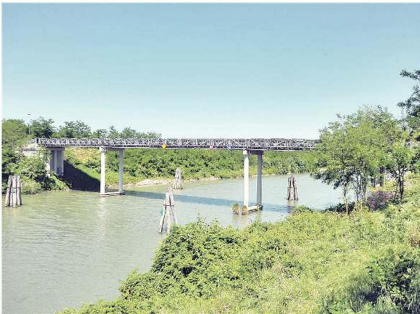
CEERGNANO Uno scorcio del Canalbianco al ponticello di Fenil del Turco: il passaggio delle chiatte danneggia gli argini
