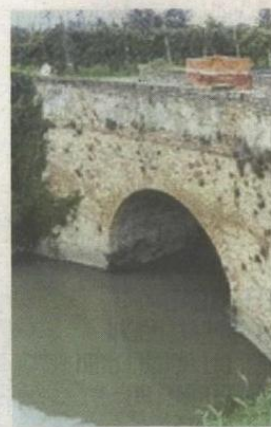
CANALETTA Parte la sistemazione dei quattro ponti
