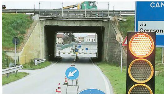
Una fase dei lavori al sottopasso autostradale di Lissaro
