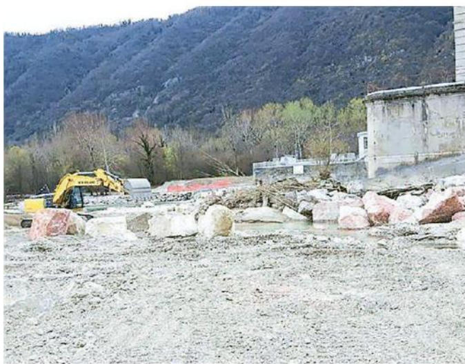
Lavori del Consorzio sul Piave in secca all'Opera di Presa di Fener
