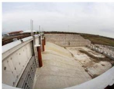
La "porta" di ingresso del bacino di laminazione di Caldogno
