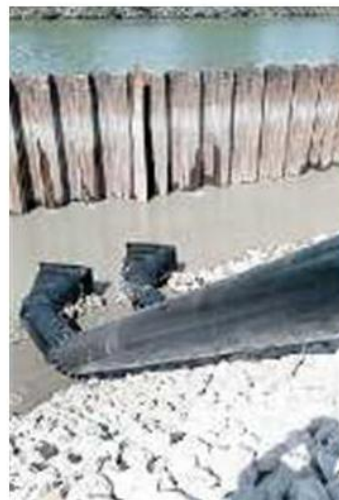
I LAVORI Già completati interventi sul Brenta
