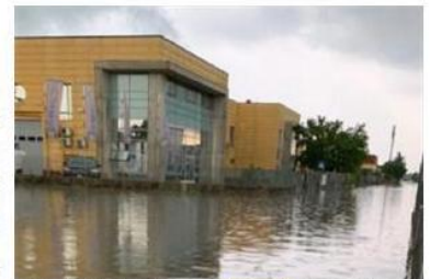
La pioggia abbondante ha causato allagamenti nella zona industriale
