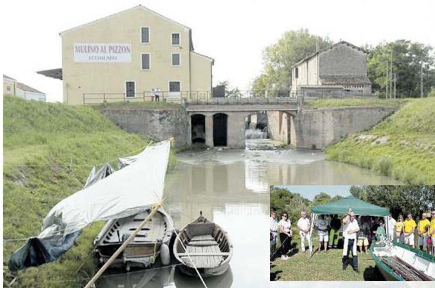
MULINO STORICO Il complesso del Pizzon vicino a Scortico e Canalbianco: a ottobre la struttura era stata danneggiata da un incendio
