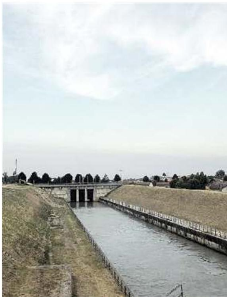
SPERONE BOVA Quasi ultimati i lavori del Consorzio di Bonifica
