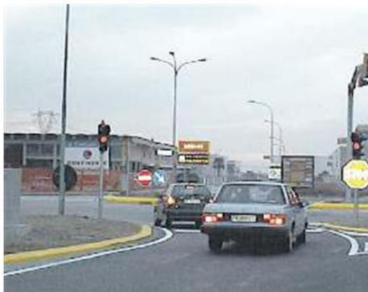
LAVORI TERZA CORSIA La zona tra lo sbocco della A4 e Malcanton
