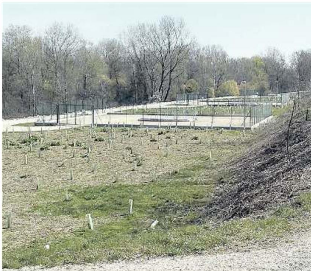
CAMAZZOLE I pozzi di emungimento realizzati lungo il fiume Brenta
