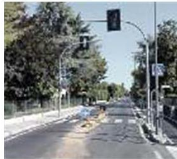
LAVORI Via Ponte Nuovo
