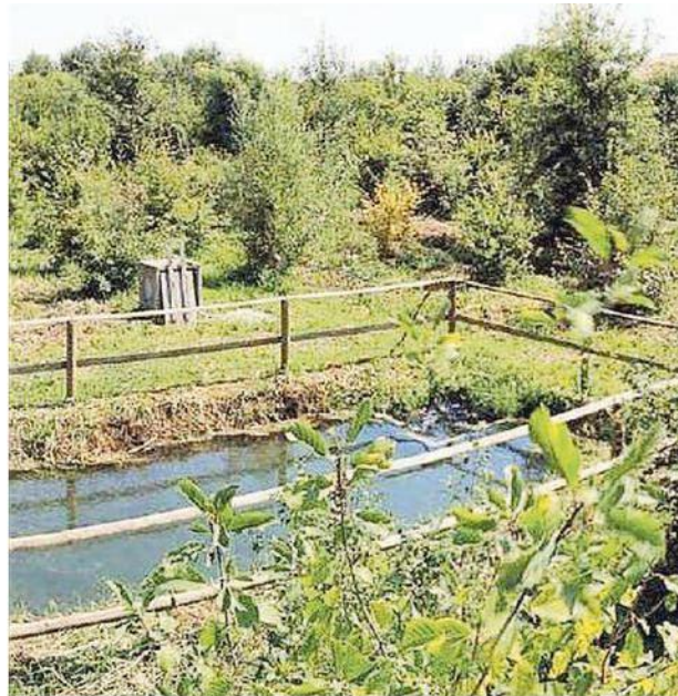
Una vasca di sedimentazione di bosco limite
