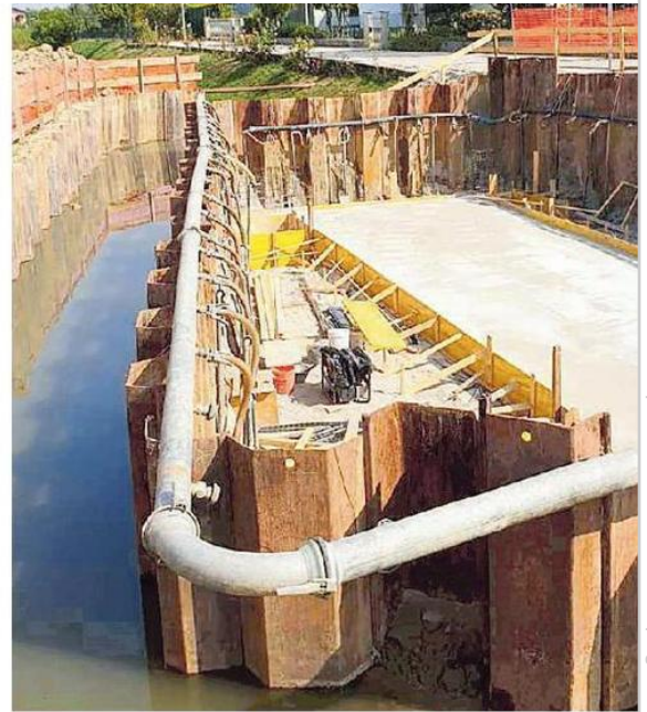
Il cantiere in via Silvio Pellico a Sarmeola di Rubano
