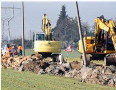
Lavori in corso in via Maccagnina DIENNEFOTO
