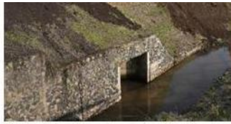
Una sponda che rientra nella recinzione del cantiere
