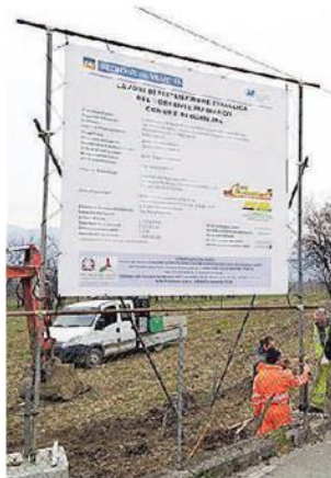
Il cartello dei lavori
