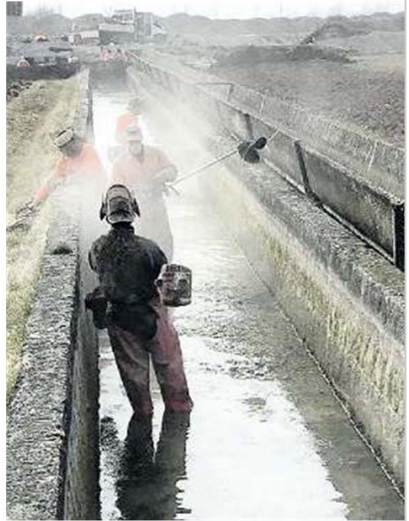
I LAVORI La pulizia dei canali di derivazione del Brentella
