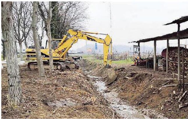
L'inizio dei lavori in questi giorni sul torrente Ru Bianco
