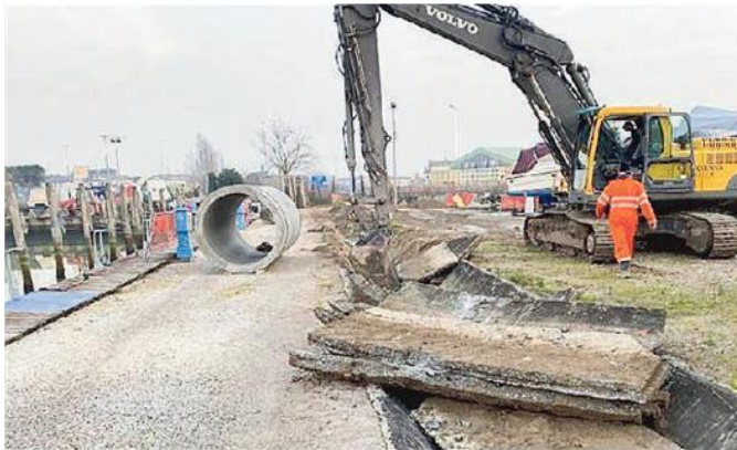
I lavori sulla sponda del canale Novissimo franata lo scorso novembre
