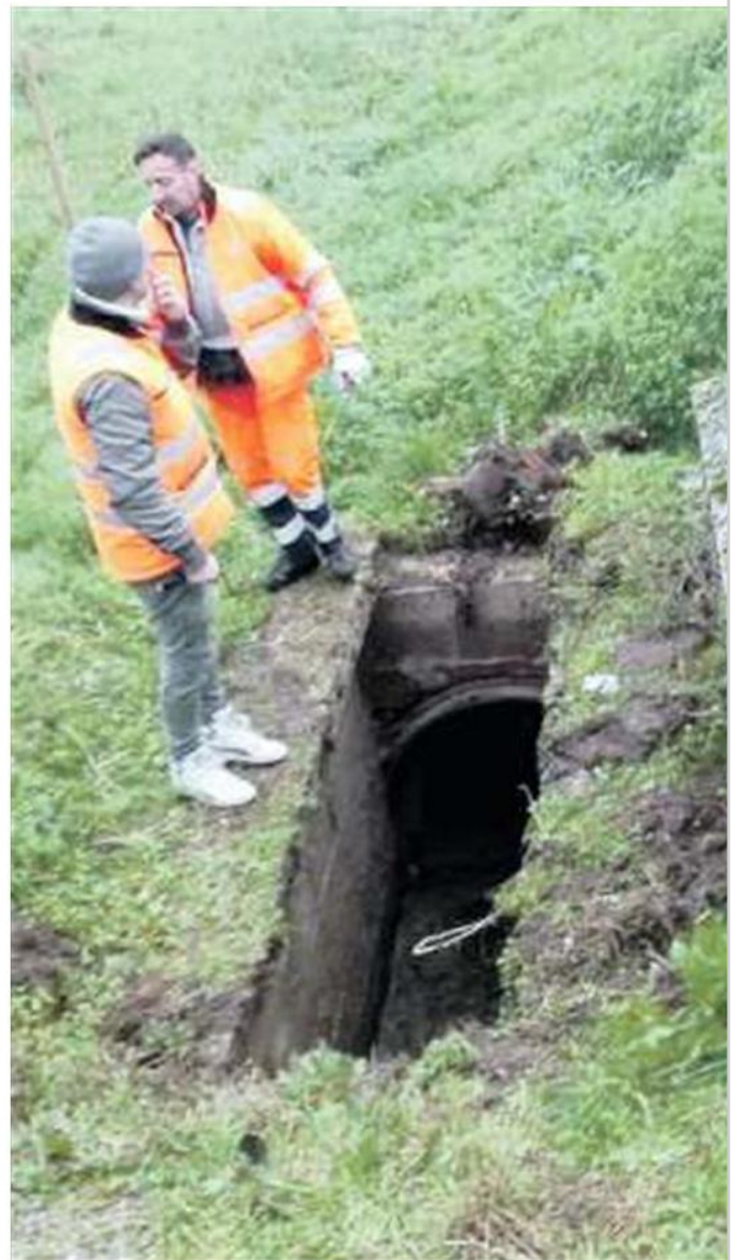
LAVORI Via San Michele ad Arlesega era sprofondata di 20 centimetri in seguito alle piogge e ai mezzi pesanti
