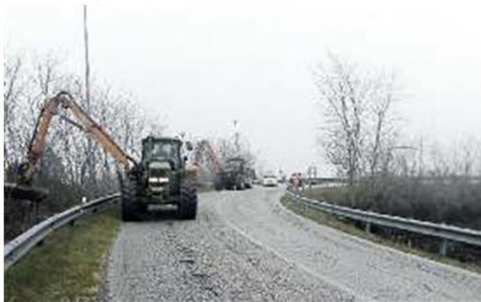
STATALE ROMEA Pulizia e sfalcio sulle rampe di accesso
