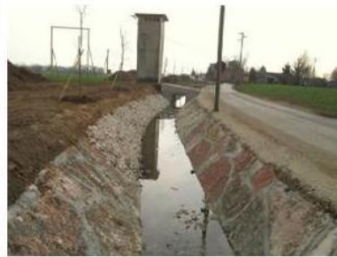
Le scarpate rivestite in pietra e le piante sul lato campagna
