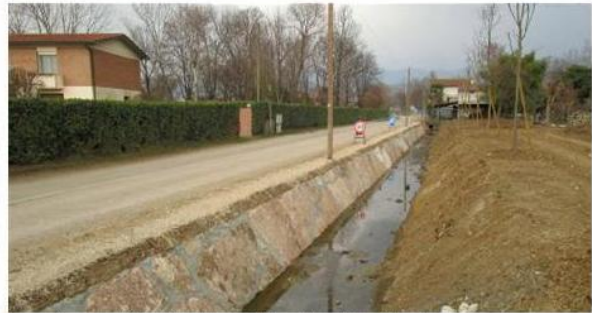
Il tratto di questo stralcio dei lavori misura 945 metri ai confini con Marostica e Schiavon
