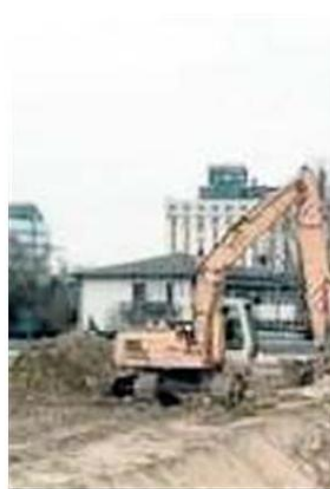
VIA SERENISSIMA Ripresi i lavori per ultimare il fossato
