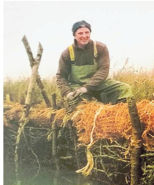
Un pescatore durante la manutenzione delle fascine anti erosione
