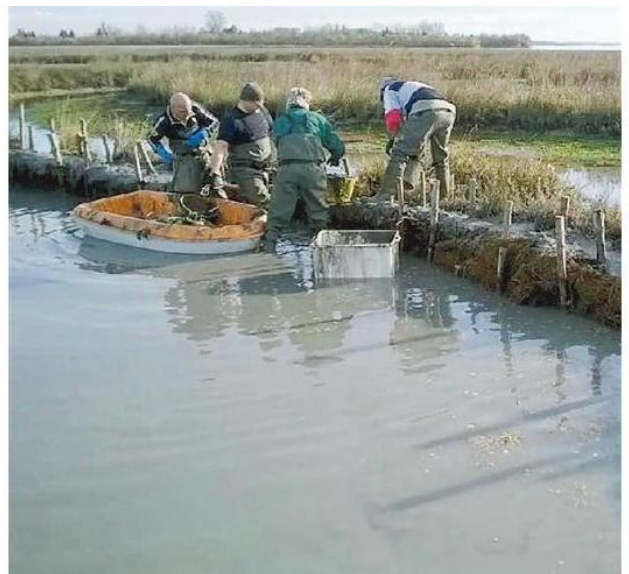
La posa delle barene del progetto Life Vimine nell'Isola dei Laghi
